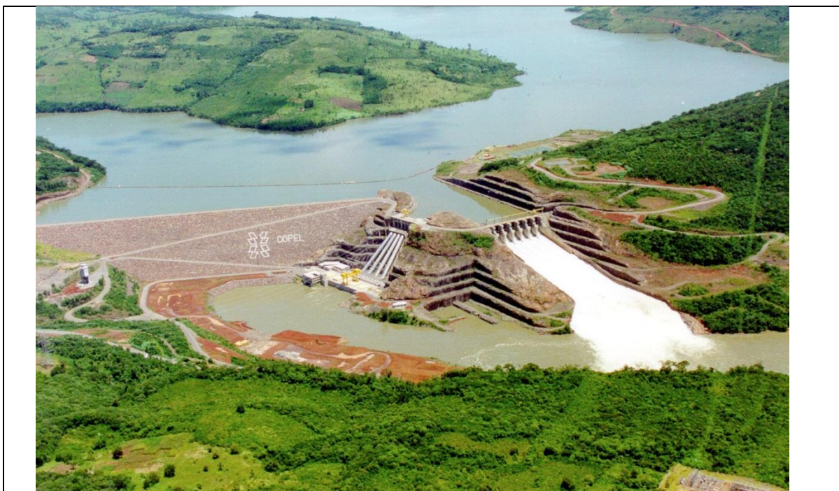
Figura 1 – Vista aérea da Usina Hidrelétrica UHE Gov. Ney Aminthas de Barros Braga (UHE GNB)
